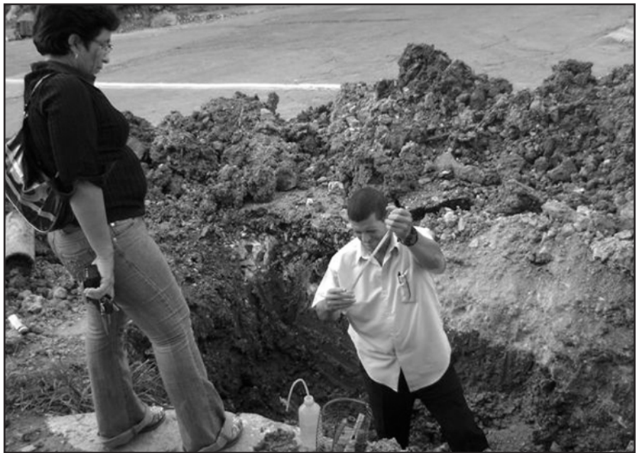
Toma de muestra de contaminación en la red
