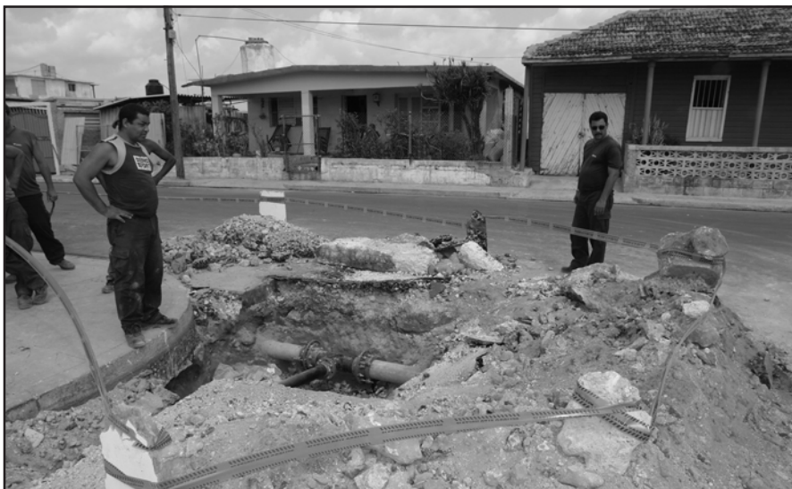
Instalación de T en red hidráulica en Santa Fe
