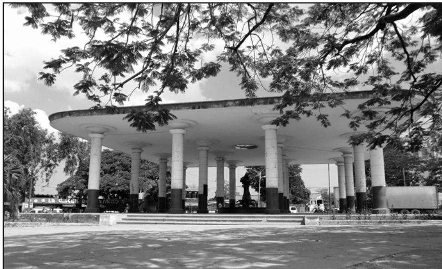
Vista panorámica donde está enclavada la fuente
