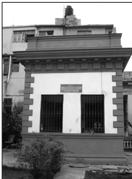
Vista de la EBAR de K y 9, en el Vedado
