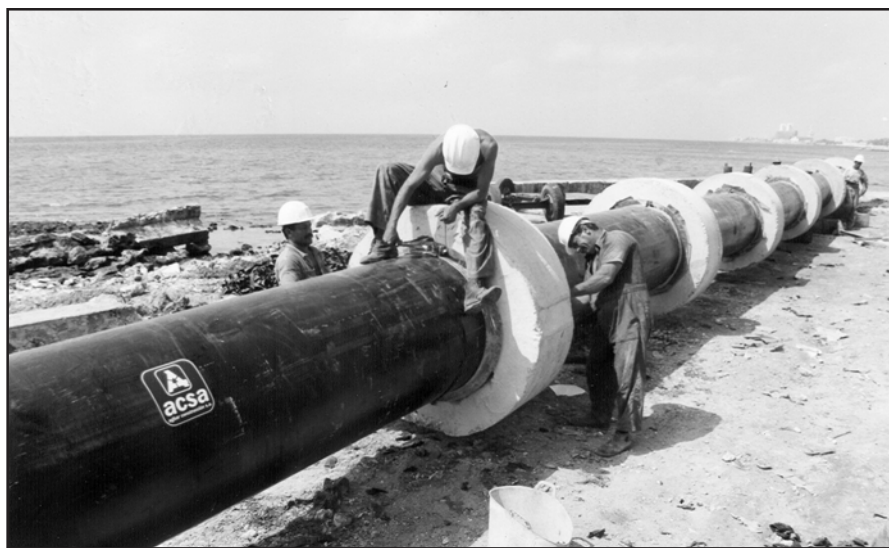
Construcción del emisario submarino
