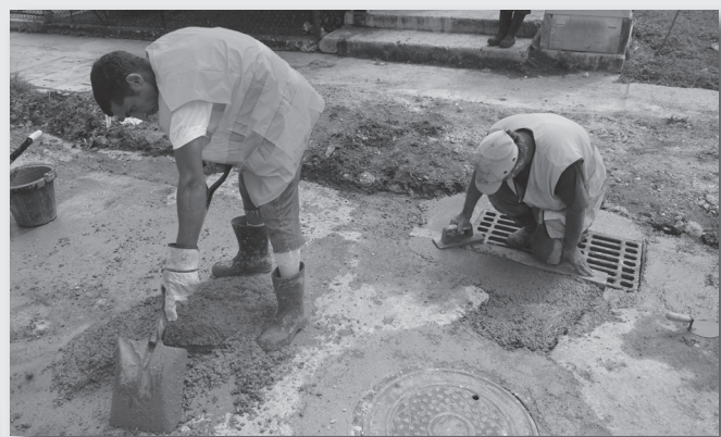
Brigada terminando sistema de alcantarillado.
