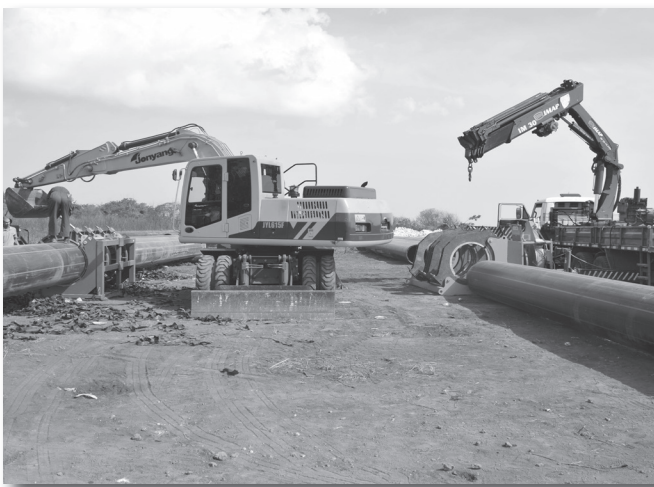
Proceso de Soldadura de las tubería de PAD.
