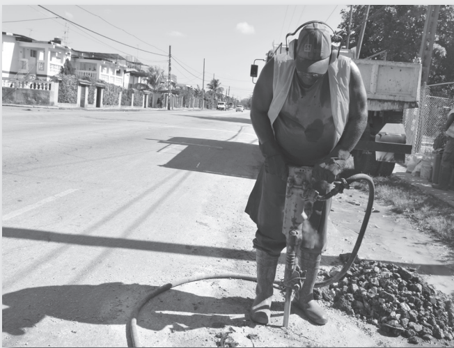
Operario manipulando el martillo hidráulico.
