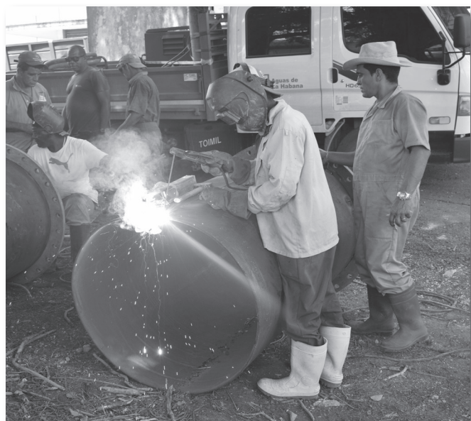
Soldador terminando tubería para empatar al conducto.
