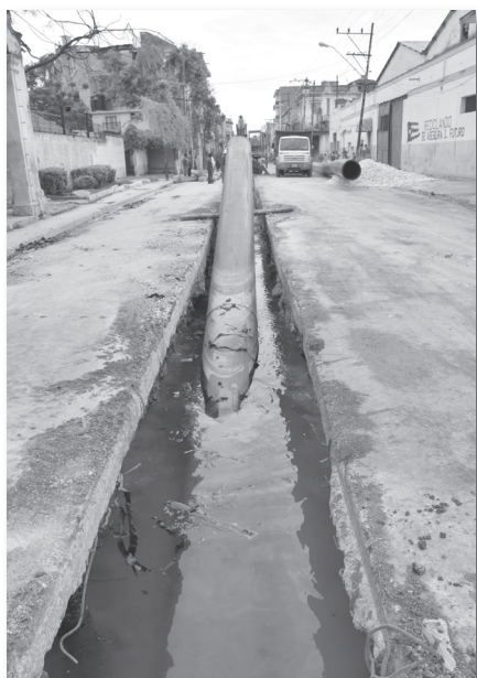
Obra de acueducto ,Vives
