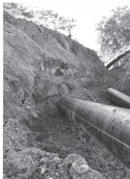
Obra de acueducto , 42 plg Cosculluela
