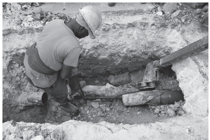
Rehabilitación de la calle Prado con la Tecnología de Topo.
