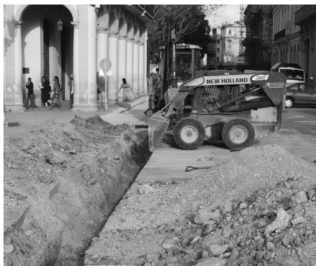
Rehabilitación de la calle Dragones .
