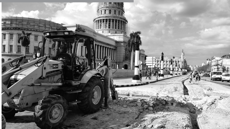
Rehabilitación de la calle Paseo del Prado.
