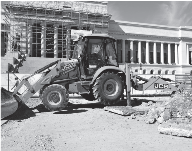
Excavación en la esquina Prado y Teniente Rey.
