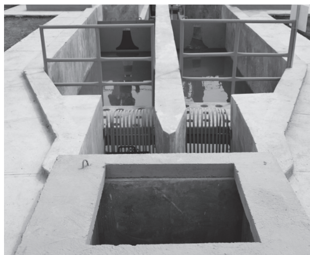
Canal Desarenador (Vista Inferior)
