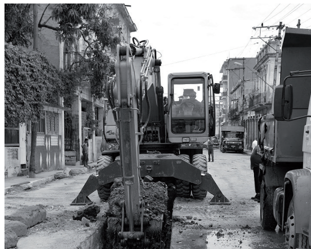
Excavación en la conductora de calle Vives, en la Habana Vieja.
