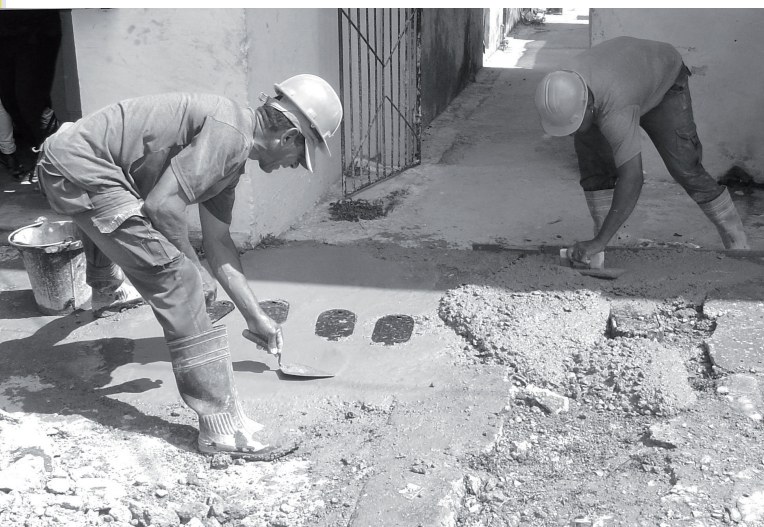
Instalación y mantenimiento de contadores de agua.
