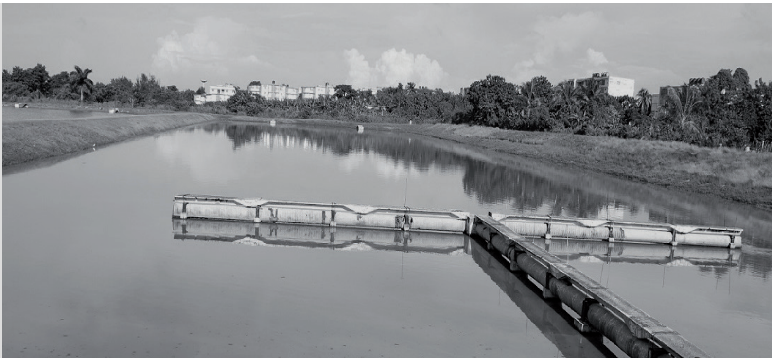
Laguna de Oxidación San Agustín Este.
