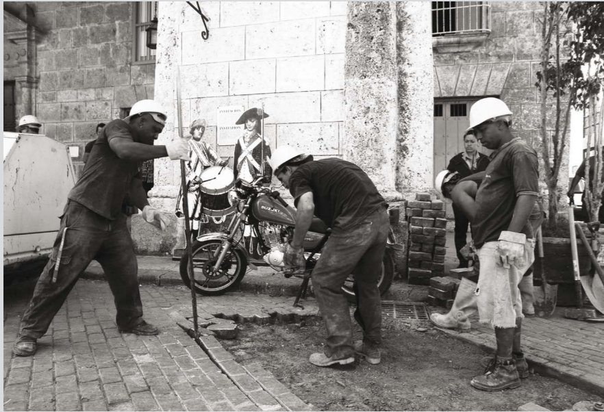
Levantamiento de adoquines. Imagen inferior: Retrocavadora en labor.
