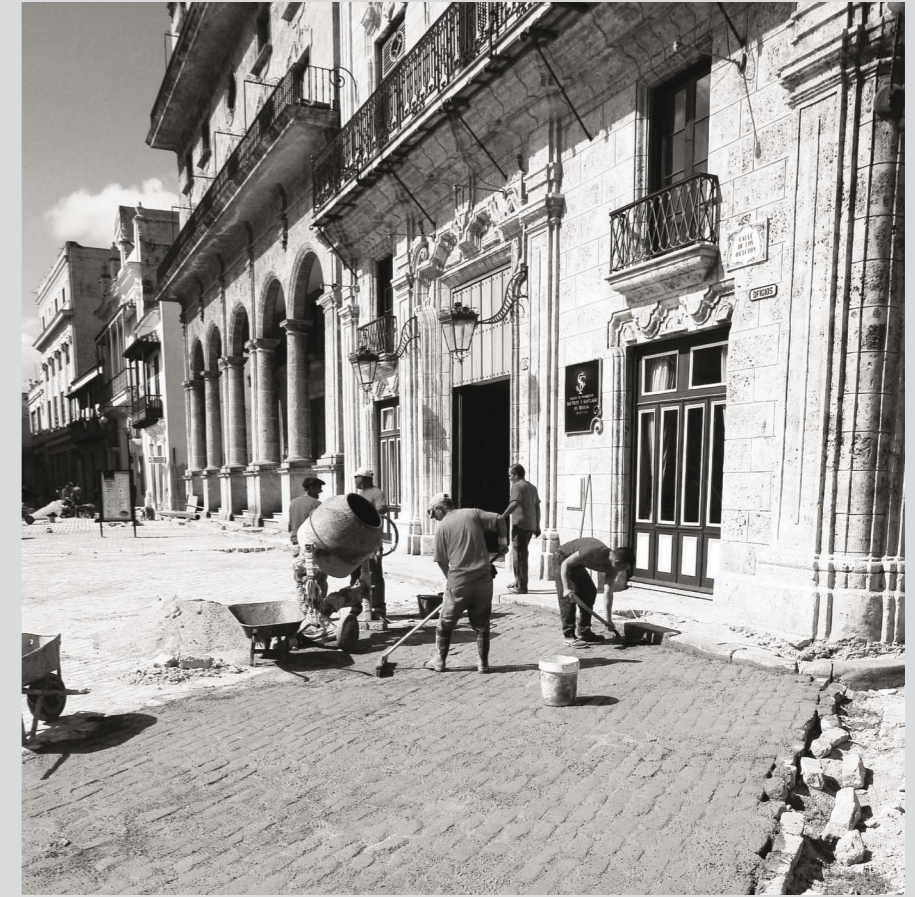
Colocación de adoquines. Imagen inferior: Obreros en labor.
