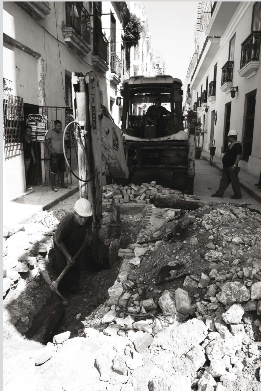
Levantamiento de adoquines. Imagen inferior: Retrocavadora en labor.
