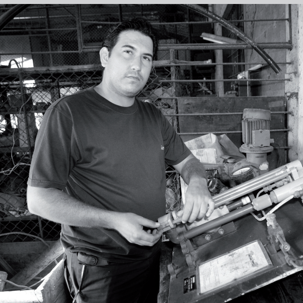
Orel González substituyendo un dosificador de cloro.
