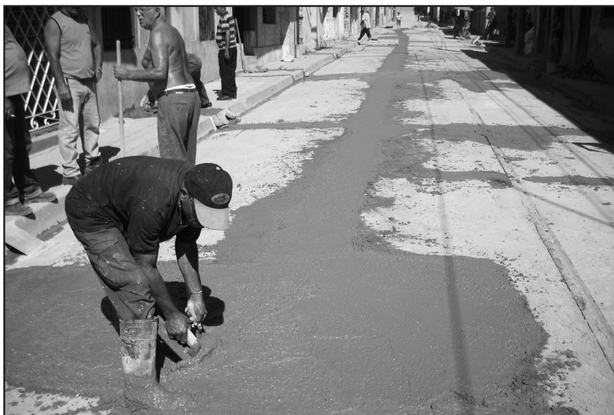
Terminación civil en redes instaladas
