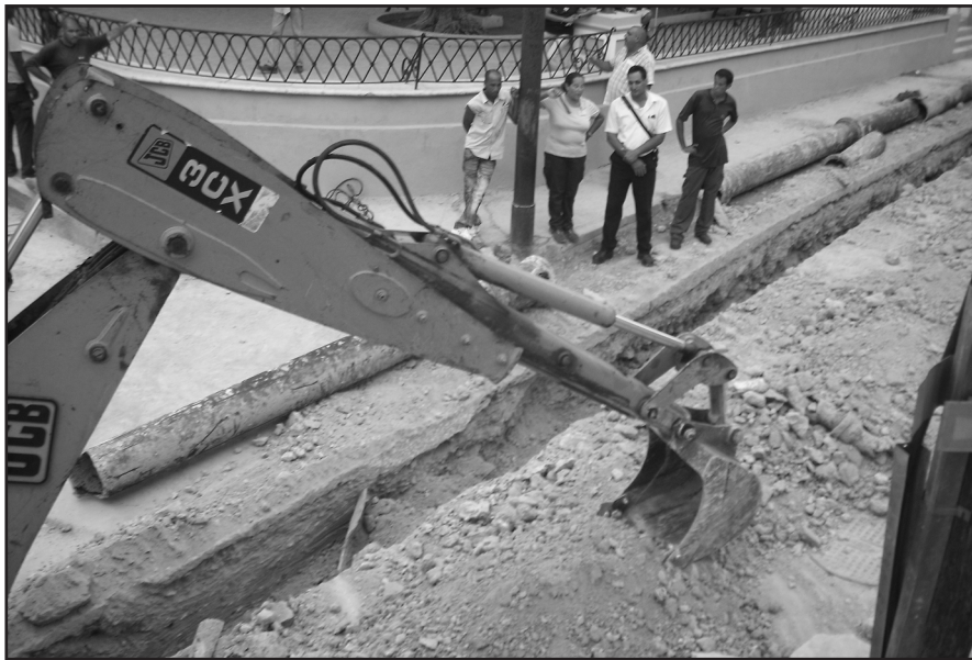
Instalación de redes en Trinidad y San Fermín
