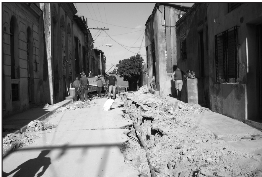
Instalación de redes en San Germán y Rastro
