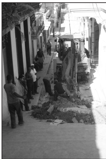
Relleno con capa de hormigón espeso
