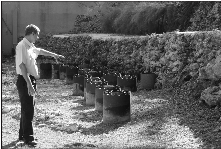
La Taza Chica deprimida totalmente
