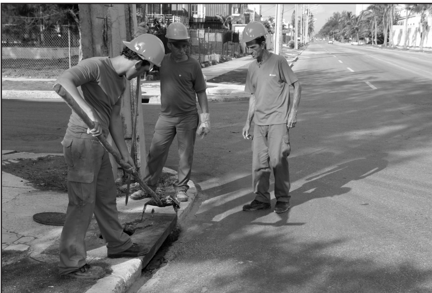
Limpieza sistemática de tragantes y alcantarillas
