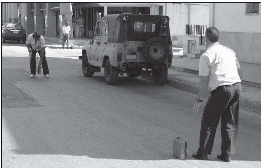
Especialistas de Pitometría en trabajos de localización
