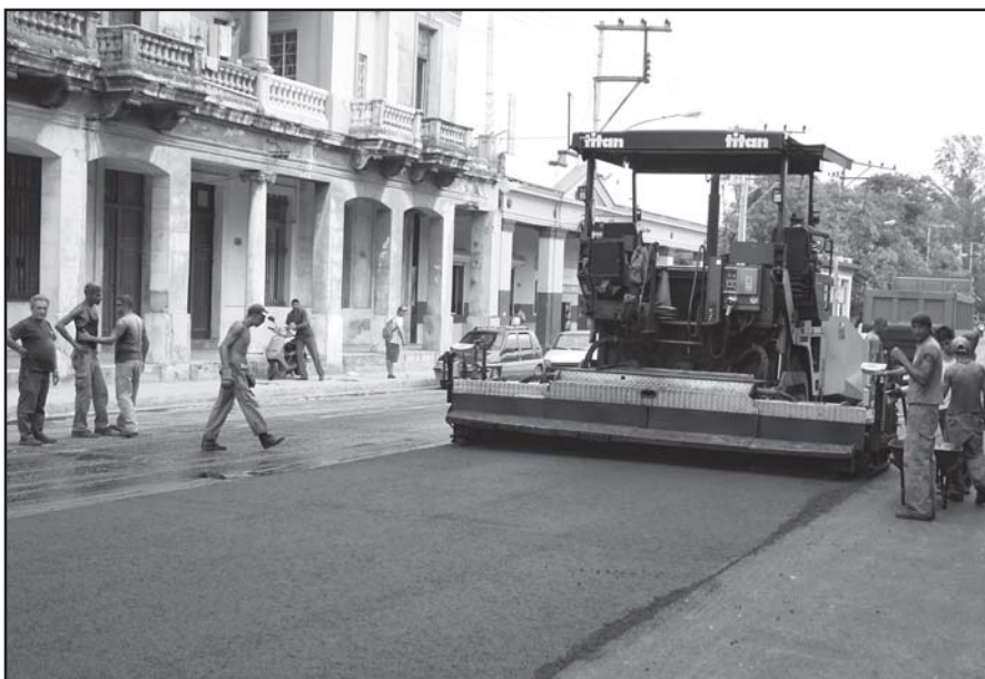
Trabajos de pavimentación
