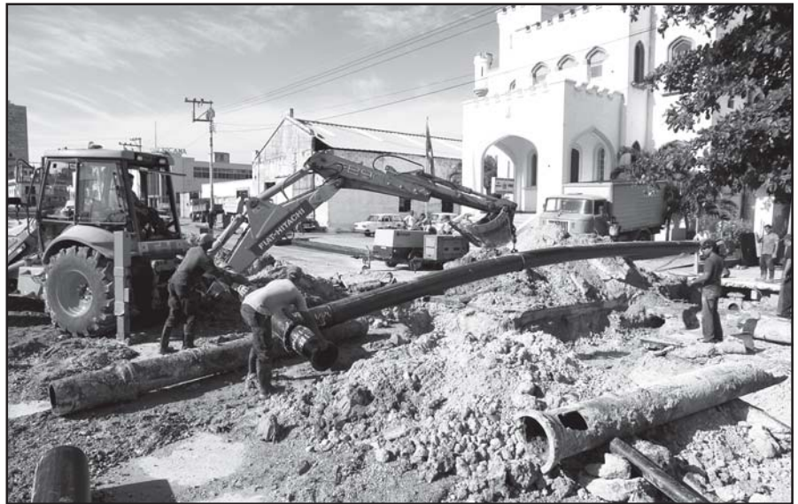
Empate de tuberías en el impulsor de Villarín
