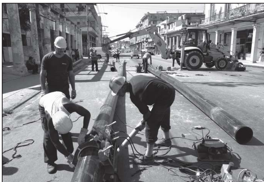
Soldadura de tuberías de alta densidad
