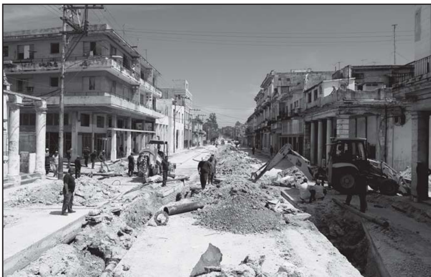
Fase de excavación general de la calle Infanta
