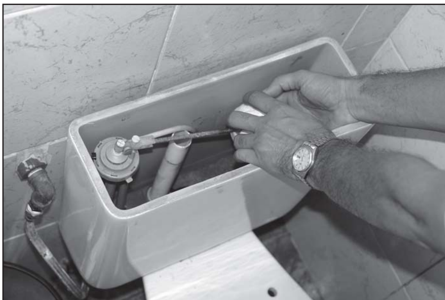
Instalación de válvula de entrada a tanque de mueble sanitario
