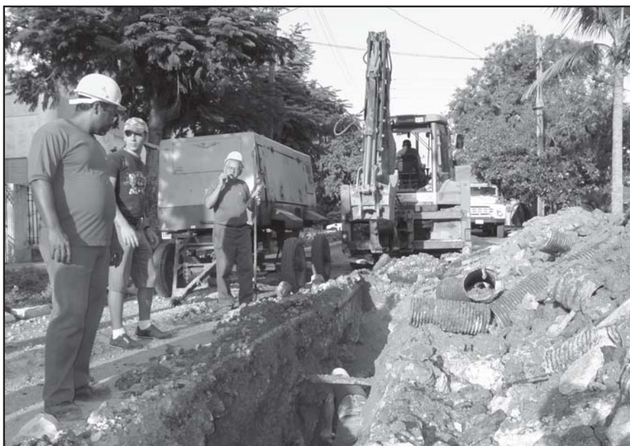
Arduo trabajo de desobstrucción en calle 2 y 19 en el Vedado
