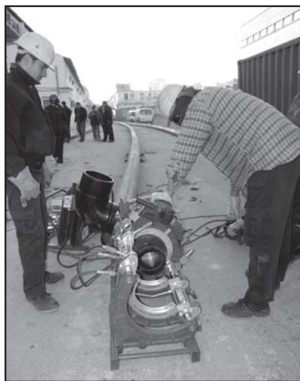
Soldadura de Codo de 250mm
