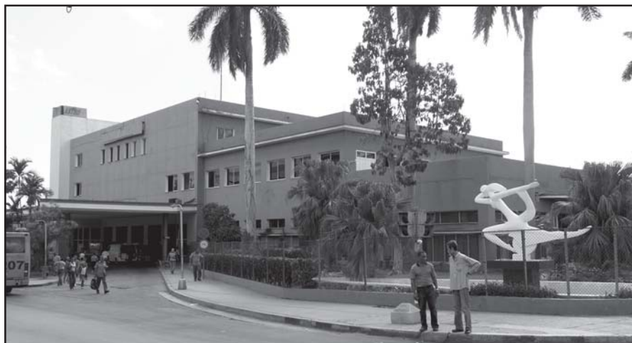
Panorámica de la Terminal de Ómnibus de la Capital donde está ubicada la Fuente
