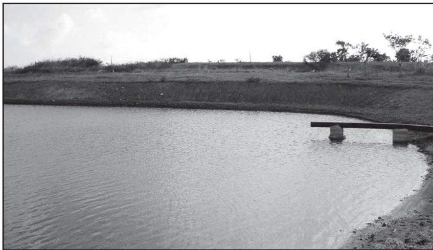
Laguna de oxidación, alternativa para el tratamiento de aguas residuales
