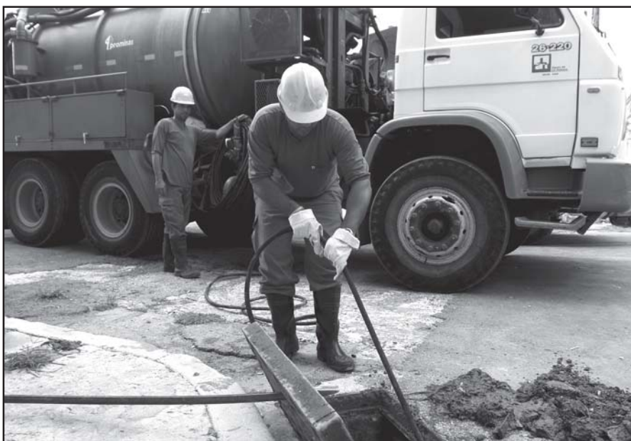
Obreros en plena labor de saneamiento en Municipio Centro Habana
