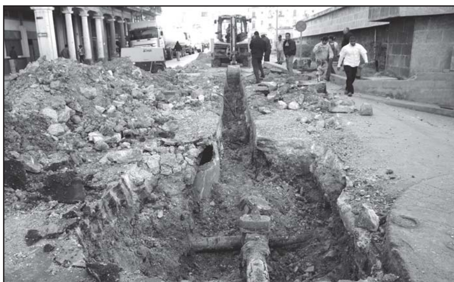
Cambio del registro en la Rehabilitación de las Redes del Hospital
