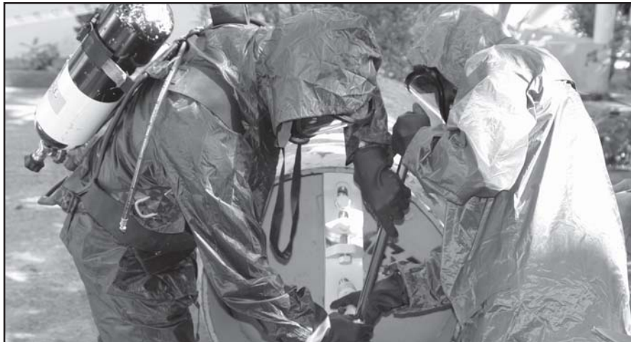
Cambio de junta de plomo a cilindro de cloro con las normas requeridas
