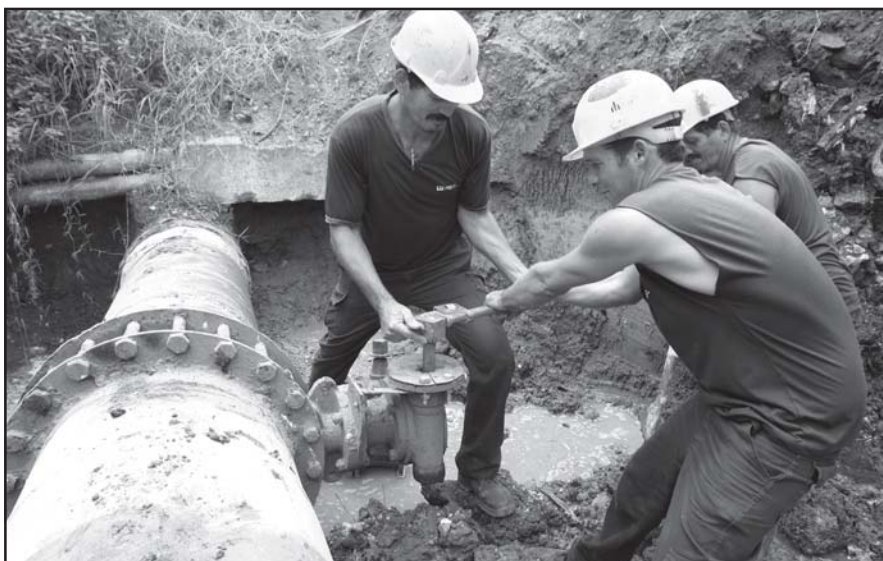
Cambio de válvula de 24 pulgadas en el reparto San Agustín
