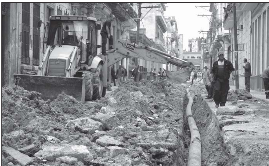
Tubería colocada y lista para conectar en calle Lucena, Centro Habana
