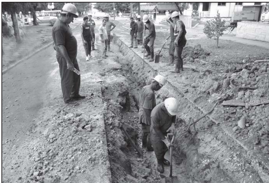
Trabajadores de Saneamiento rehabilitan la calle Paseo
