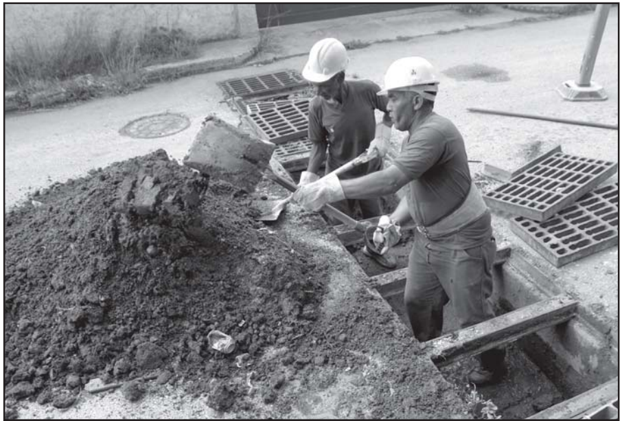
Limpieza y desobstrucción de alcantarillas en el el Municipio Playa
