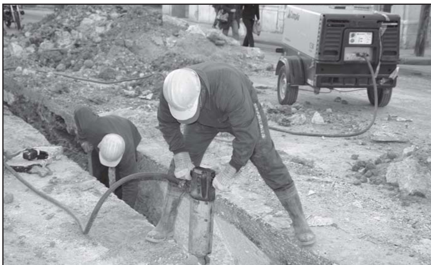
Rebajando imperfecciones en la zanja con el martillo neumático
