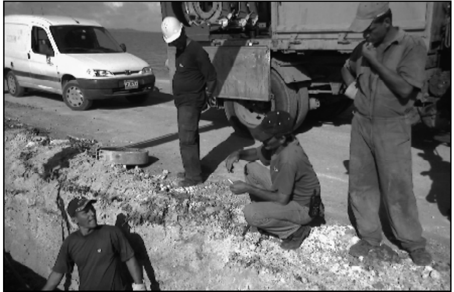
Trabajadores de Aguas de La Habana en plena labor de recuperación.
