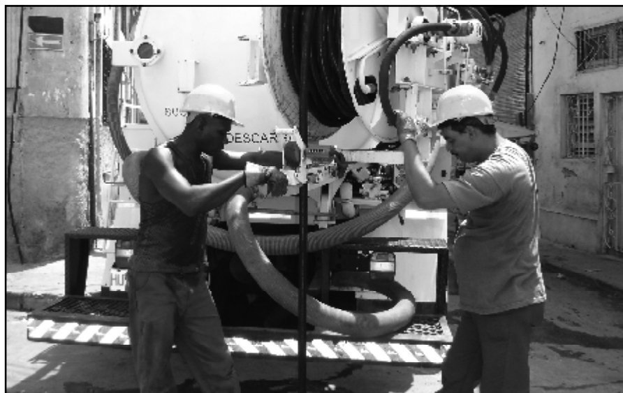
Desobstrucción de alcantarillas ante la inminencia del evento.
