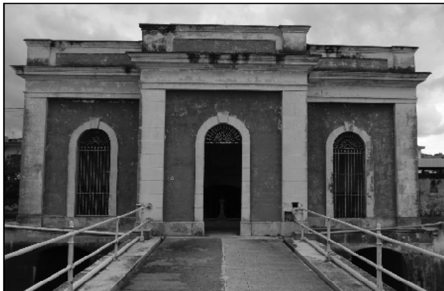
Caseta de captación del Canal de Albear.
