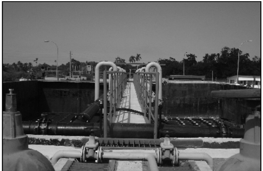
Panorámica de la Planta de Tratamiento.
