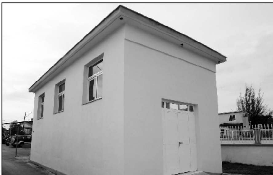
Nuevo Archivo Técnico reconstruido por Edificación y Montaje.
