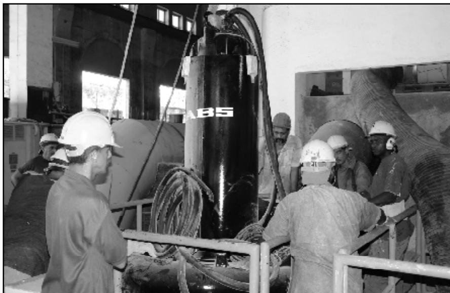
Instalación de una Bomba sumergible en Casa Blanca.
