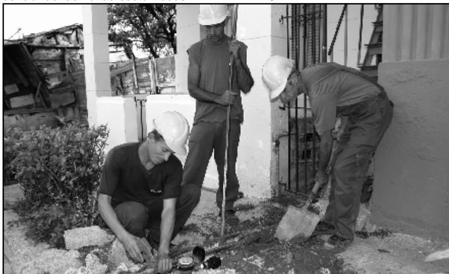
Obreros de la Base en el metraje masivo.
