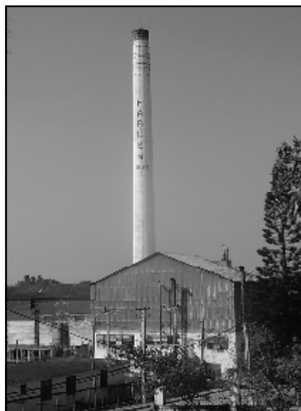
Vista exterior del CAI Harlem.
