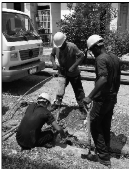
Rehabilitación de Redes en Luyanó.
