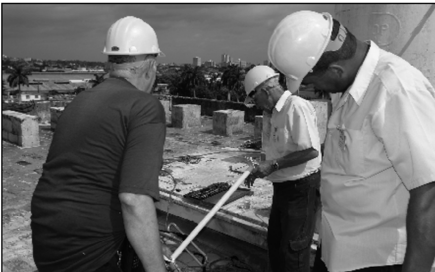
Equipo en pleno montaje de antenas en la Sede Social.
