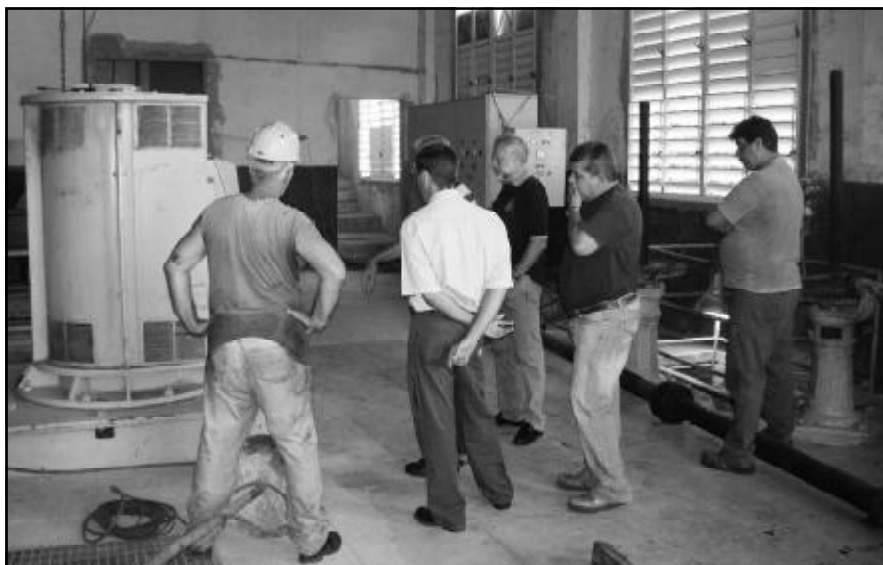
José M. Tura, Dir. General chequea las obras junto a técnicos y especialistas.
