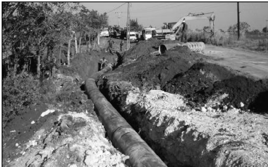
Rehabilitación de la conductora de Ariguanabo.
