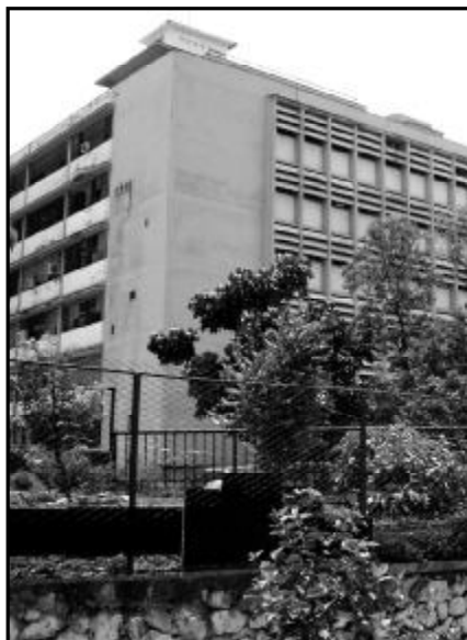
Hospital «Fajardo», beneficiado con un colector de alcantarillado.
