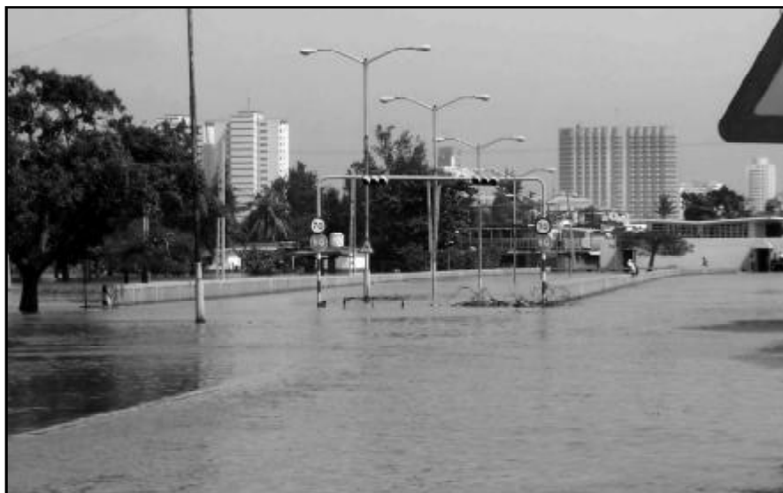
Huracán Wilma, récord de penetraciones del mar (Túnel de Linea).
