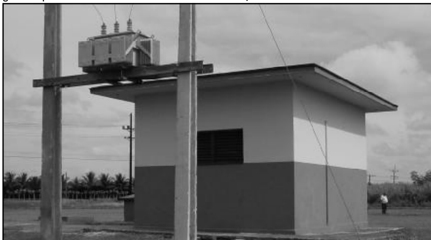
Sustitución de transformadores en pozos de Cuenca Sur.
