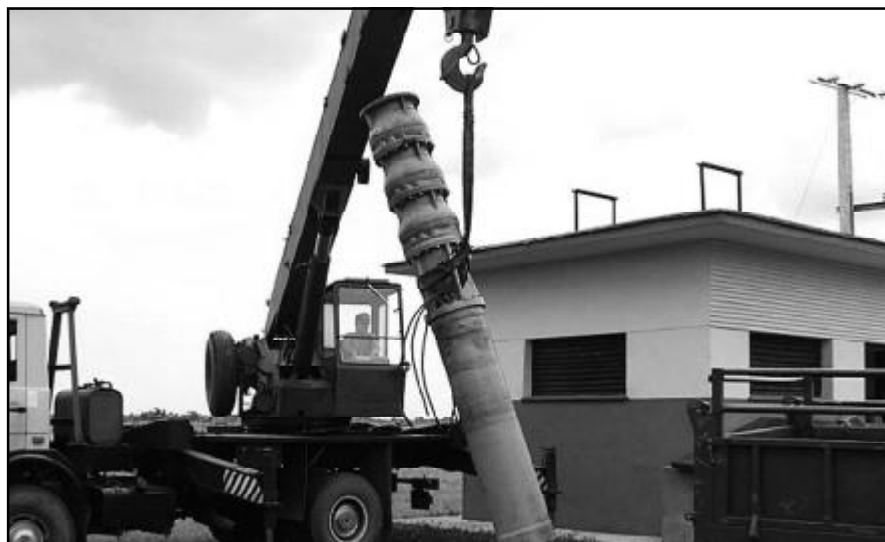
Instalación de Bomba Sumergible.
