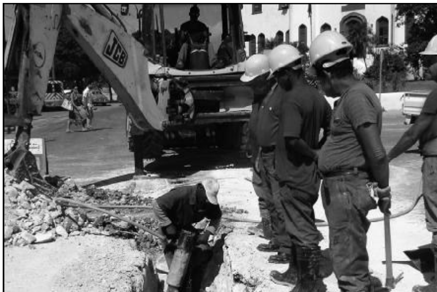
Brigada de la Base Saneamiento Oeste .
