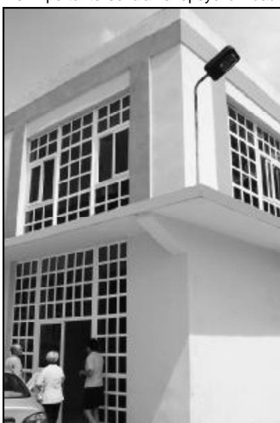
Vista Parcial de las nuevas oficinas.
