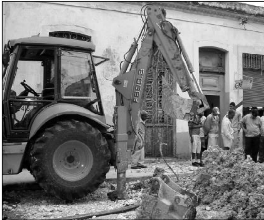
Reparación de Salidero en Lawton .
