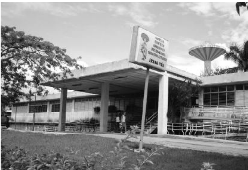
Hospital «Frank País», beneficiado con las inversiones en Drenaje y Alcantarillado.
