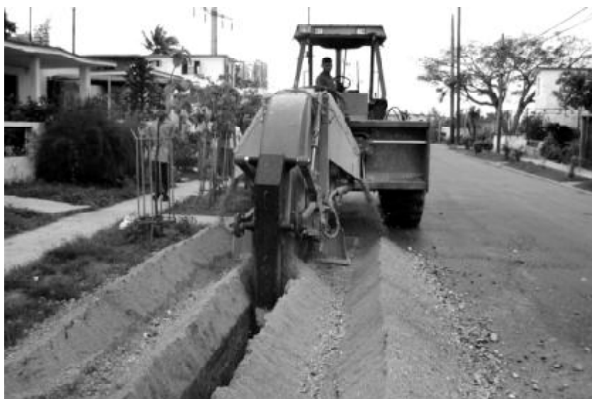
Zanjadora, equipo de mínimo impacto al entorno.
