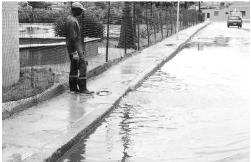
Salidero en parque Maceo esquina Malecón.
