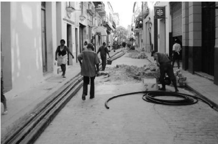
Rehabilitación de redes con el Topo, en el Centro Histórico de La Habana Vieja.
