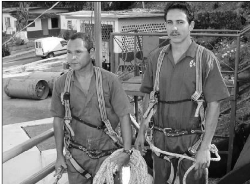
Chapeadores de los taludes en Vento con dispositivos de seguridad para labores en alturas.
