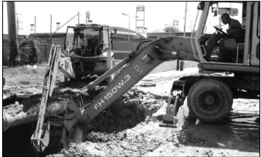
Retroexcavadora en obra de Vía Blanca.
