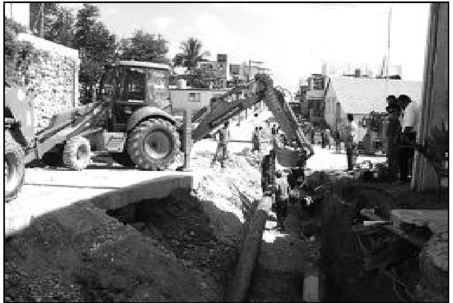
Instalación Hidráulica (Trabajo en Conjunto).
