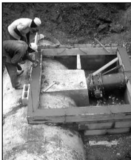
Nuevo pozo de el Rincón.
