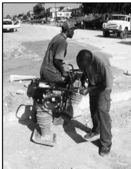
Trabajo de compactación.
