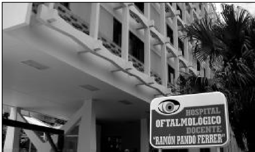
Hospital beneficiado con nuevas instalaciones hidráulicas.
