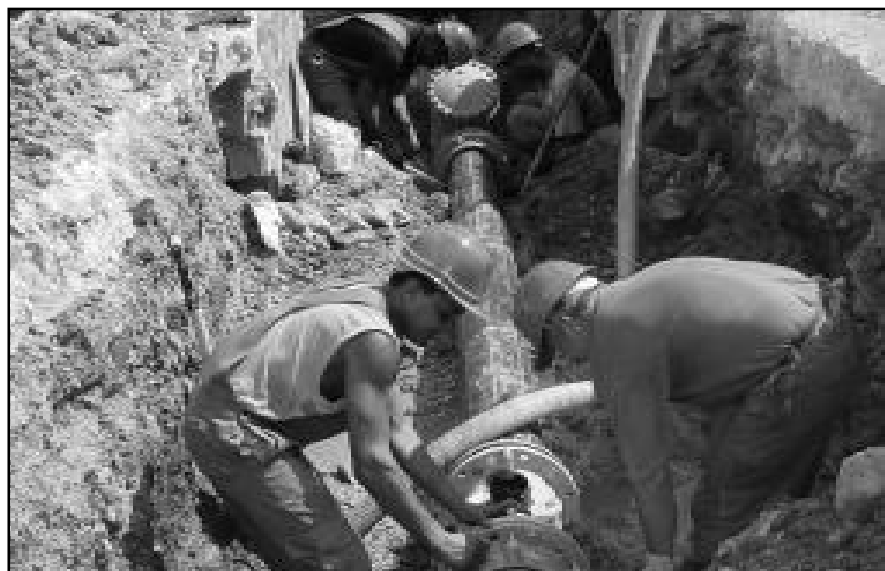
Brigada de la Base Metraje, instalando un medidor a un cliente gran consumidor.
