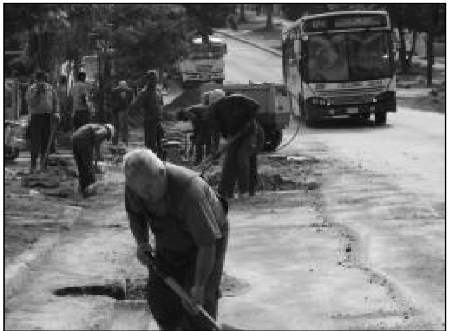
Preparación para Tape y Hormigoneo en Vía Principal.
