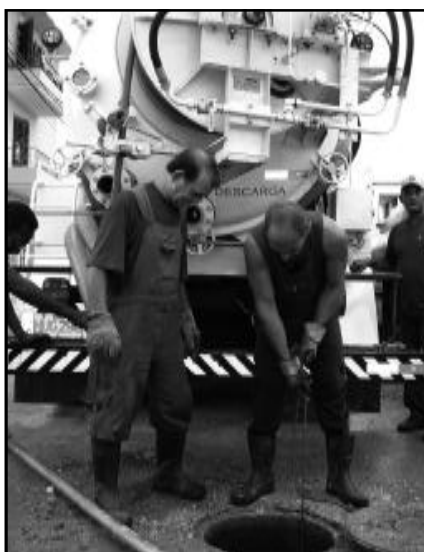
Labores para el saneamiento ambiental.
