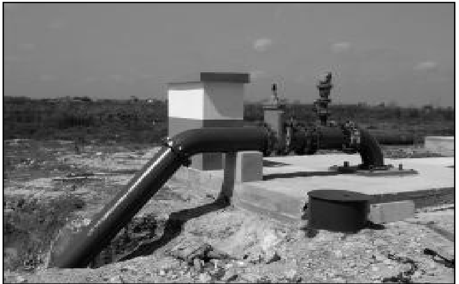
Programa sequía. Rehabilitación y Montaje de Bomba Sumergible, Rincón 3.
