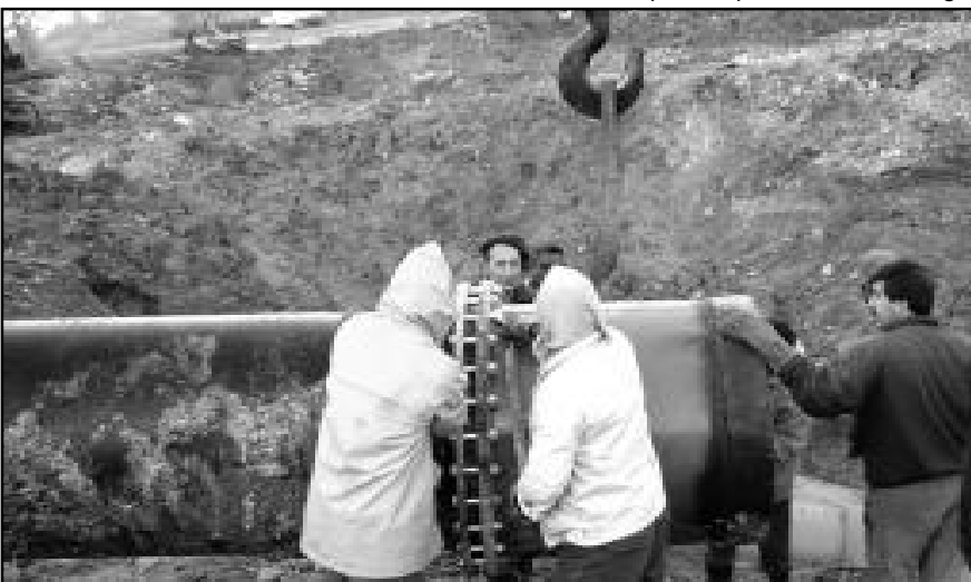
Trabajadores de Base G. Conductoras, ejecutando el empate de la obra de Cosculluela
