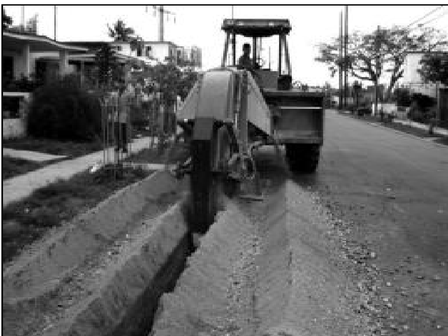
Corte en la vía con Zanjadora.
