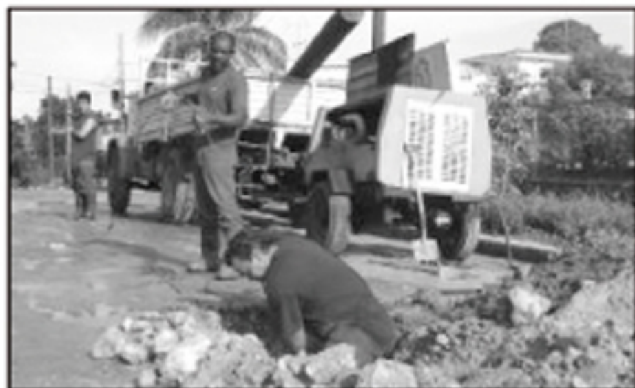
Instalación de un nuevo entorque de alcantarillado
