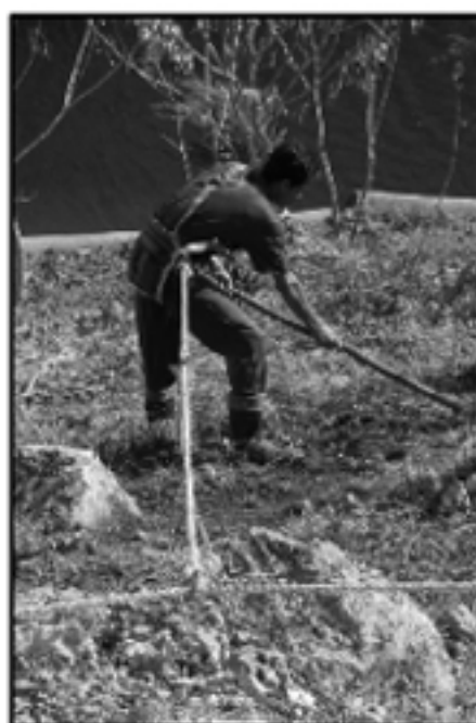
Ejecución actual de los trabajos.
