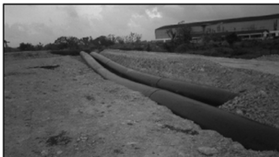
Tuberías de la nueva conductora.
