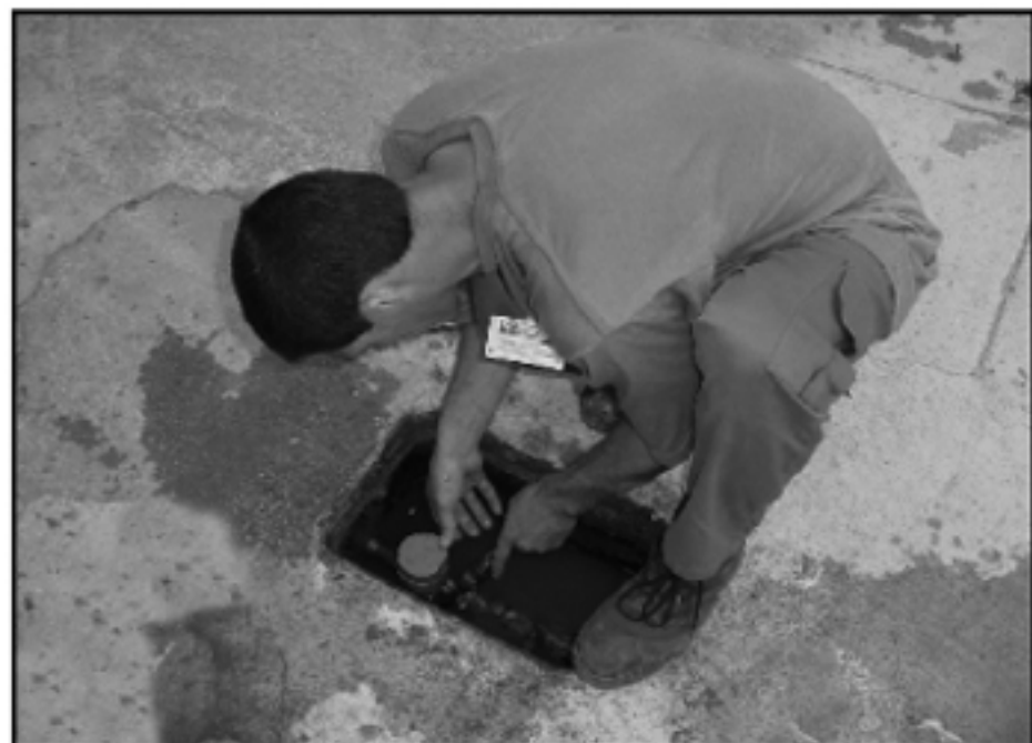
Operario retirando metrocontador.
