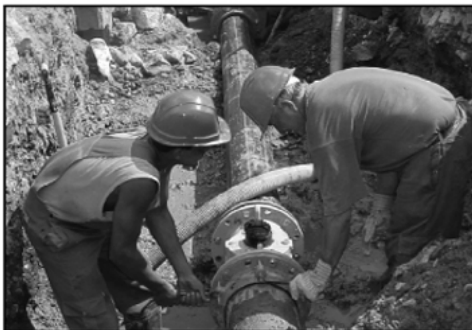
Nueva instalación de metrocontador.
