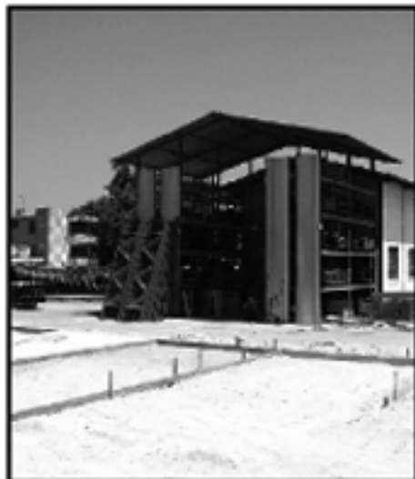
Almacén autoportante y otro en construcción.
