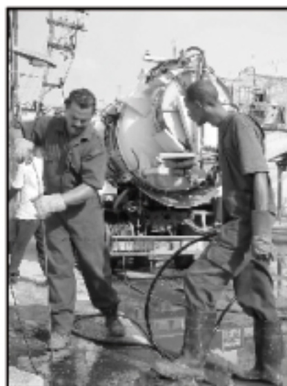
Desobstrucción de entronque.
