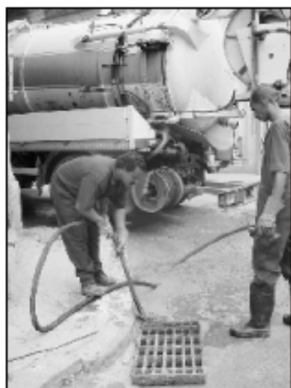
Desobstrucción de Alcantarillado.
