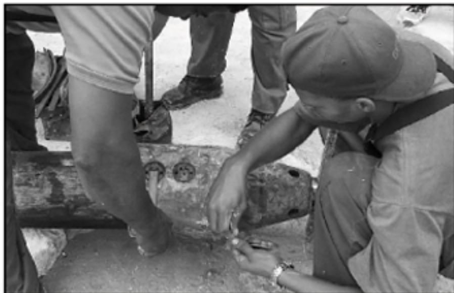
Utilización del topo en la rehabilitación de redes.
