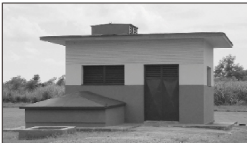
Caseta de pozo después de la remodelación.
