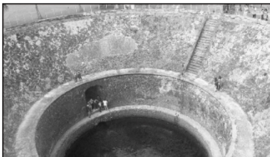
Vista de la Taza de Captación de Aguada del Cura, donde desemboca un sistema de galerías de infiltración a nivel profundo con agua pura de manantiales.
