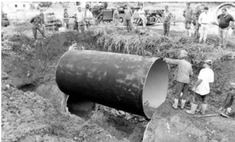
*Sustitución de un tramo del tubo de 78 pulgadas de diámetro, de la Conectora Cuenca Sur.*
