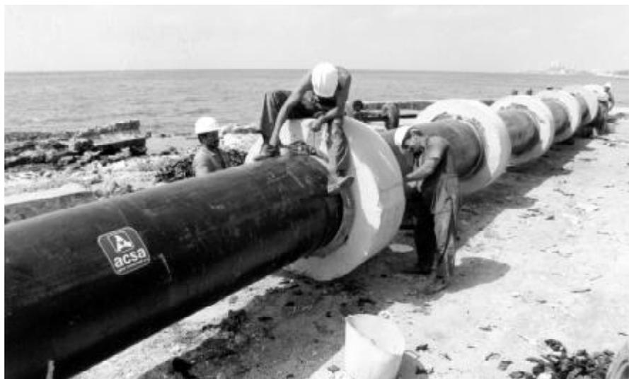
*Uno de los tramos de la tubería de 0,9 metro de diámetro con los que se construyó el emisario submarino de La Puntilla, en el río Almendares.*
